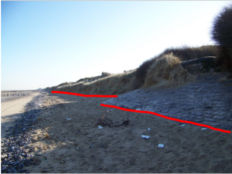
Digue de Sangatte – extrémité ouest
